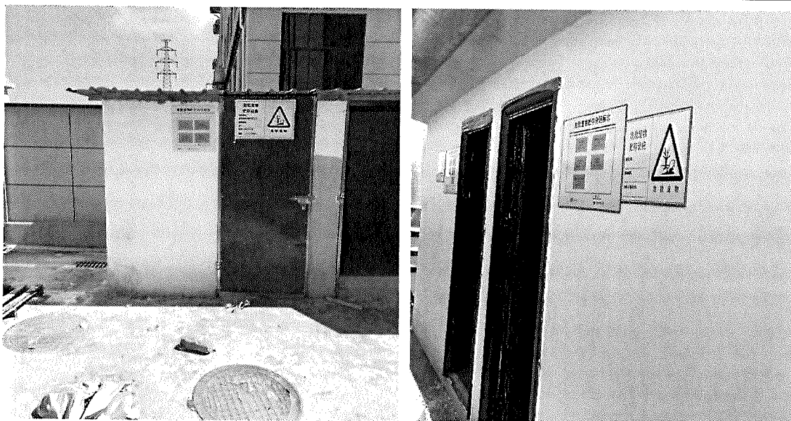
图 3-6 危废暂存间照片
