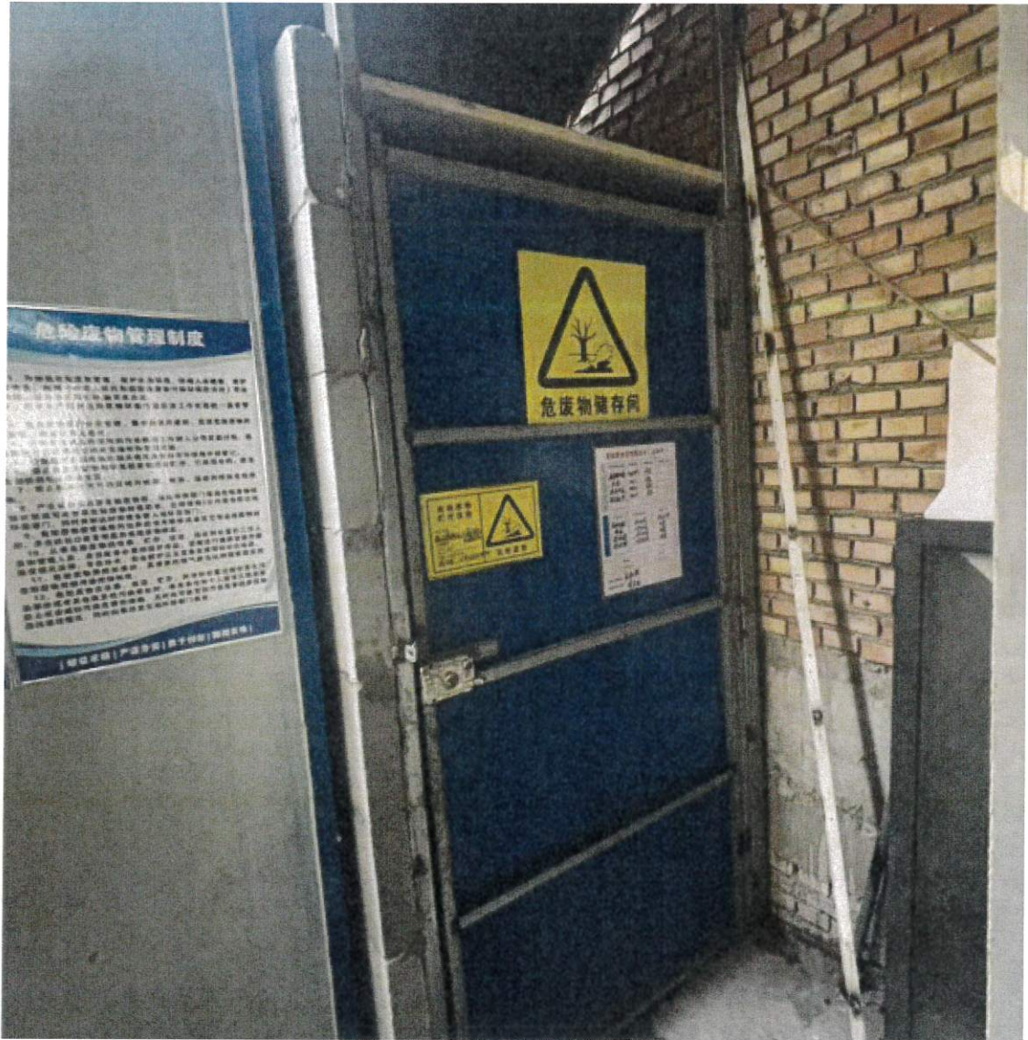
图 3-7 危废暂存间照片
