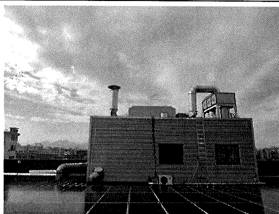
存在问题的立式喷淋塔更换为效果更好的气旋塔喷淋装置，规范了排放口建设
