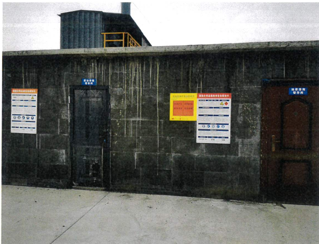
图 3-7 危废暂存间照片
